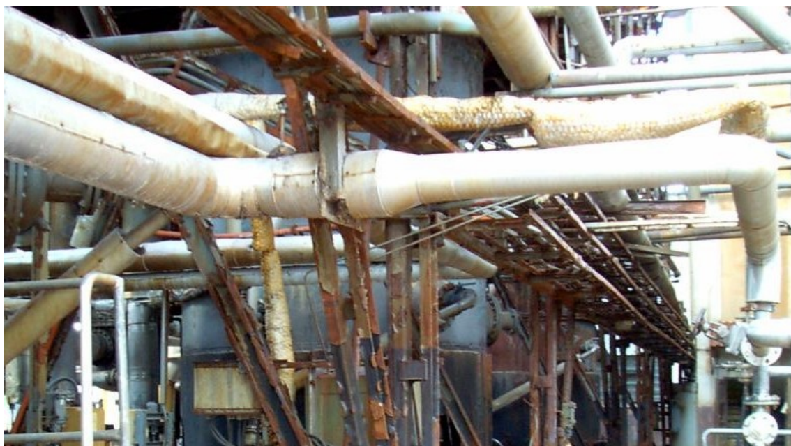
Foto 6 : pohled na kabelové lávky podél sloupví 4
