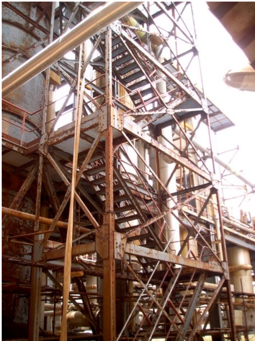
Foto 5 : Pohled na konstrukci severního schodiště – kompletní výměna
