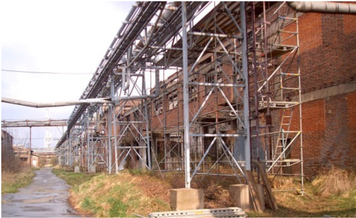
Foto 1 : celkový pohled na most E2 S 04 PK
