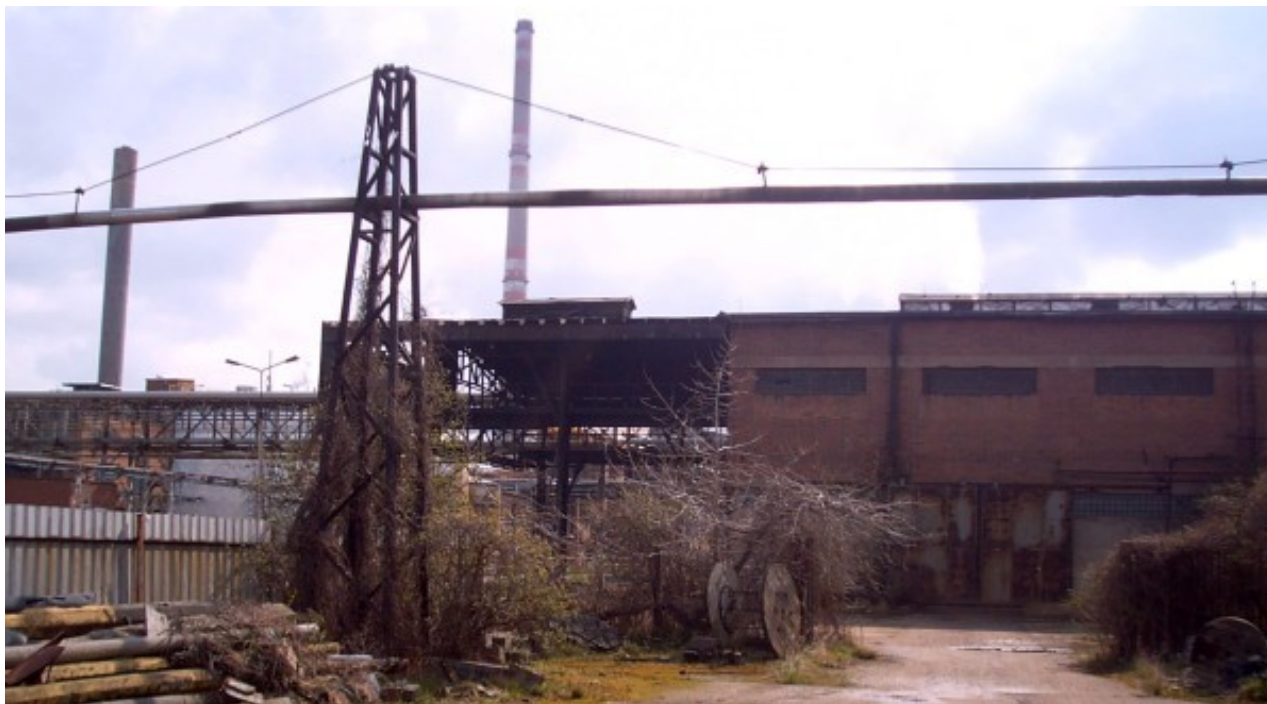
Foto 1 : celkový pohled na část mostu E2 U 02 PK s poškozeným sloupem
