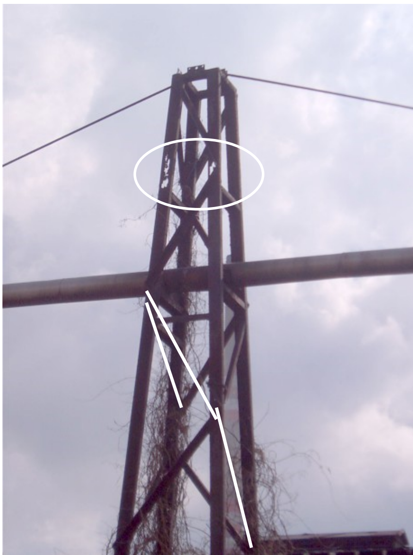
Foto 2 : korozí silně poškozené U stojiny na koruně sloupu 1, také chybí některé diagonály
