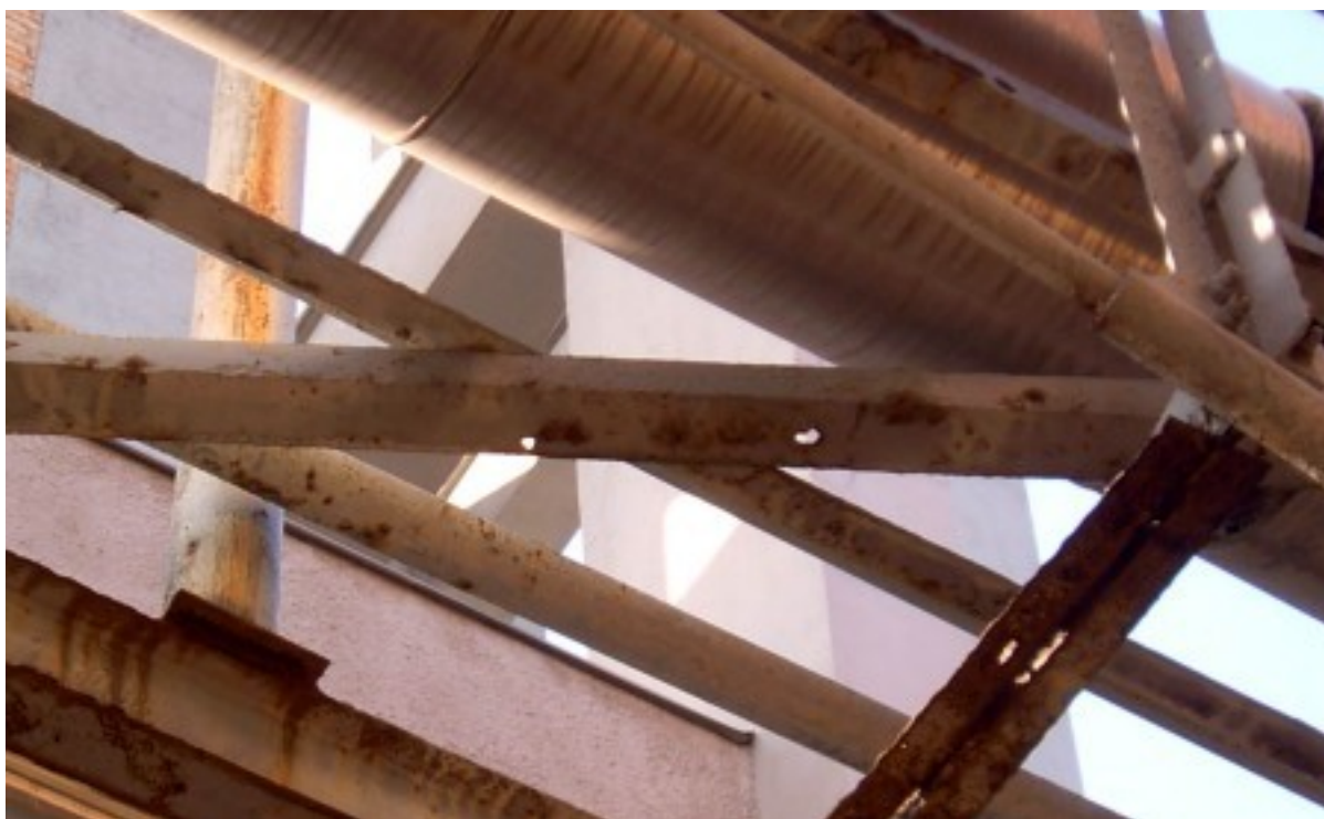
Foto 8 : lokální prokorodování L70 profilů zavětrování lávky mostu – nutné opravit přeplátováním
