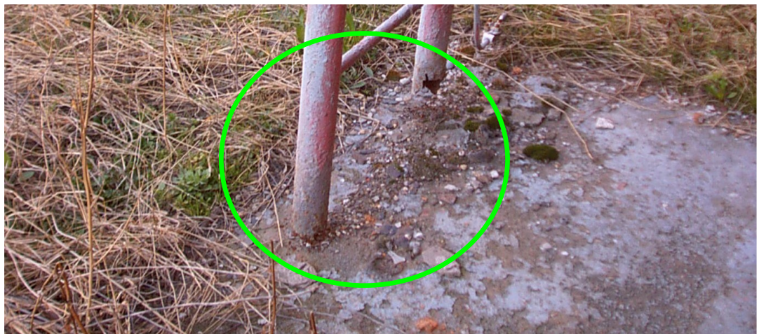
Foto 12 a 13 : v dolní a horní části viditelně prokorodovaný žebřík za sloupem 8
