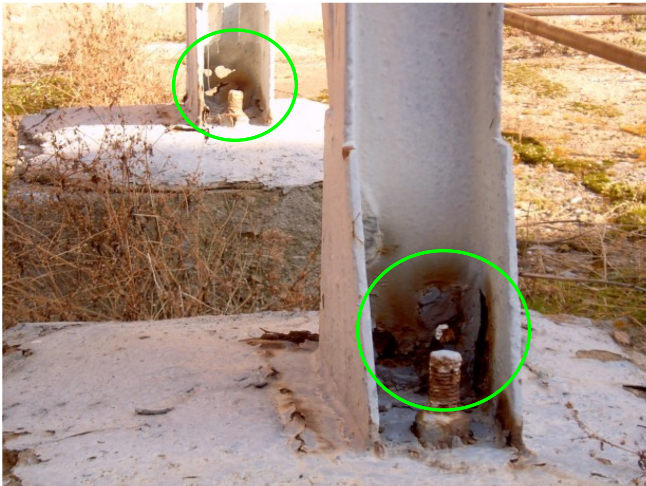
Foto 7 : prokorodované I stojiny sloupu 6 (obdobné i u sloupu 5)
