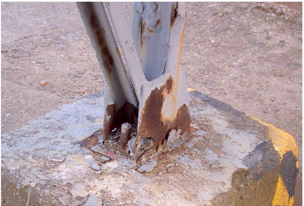
Foto 6 : prokorodované patní plechy stojiny sloupu č.3
