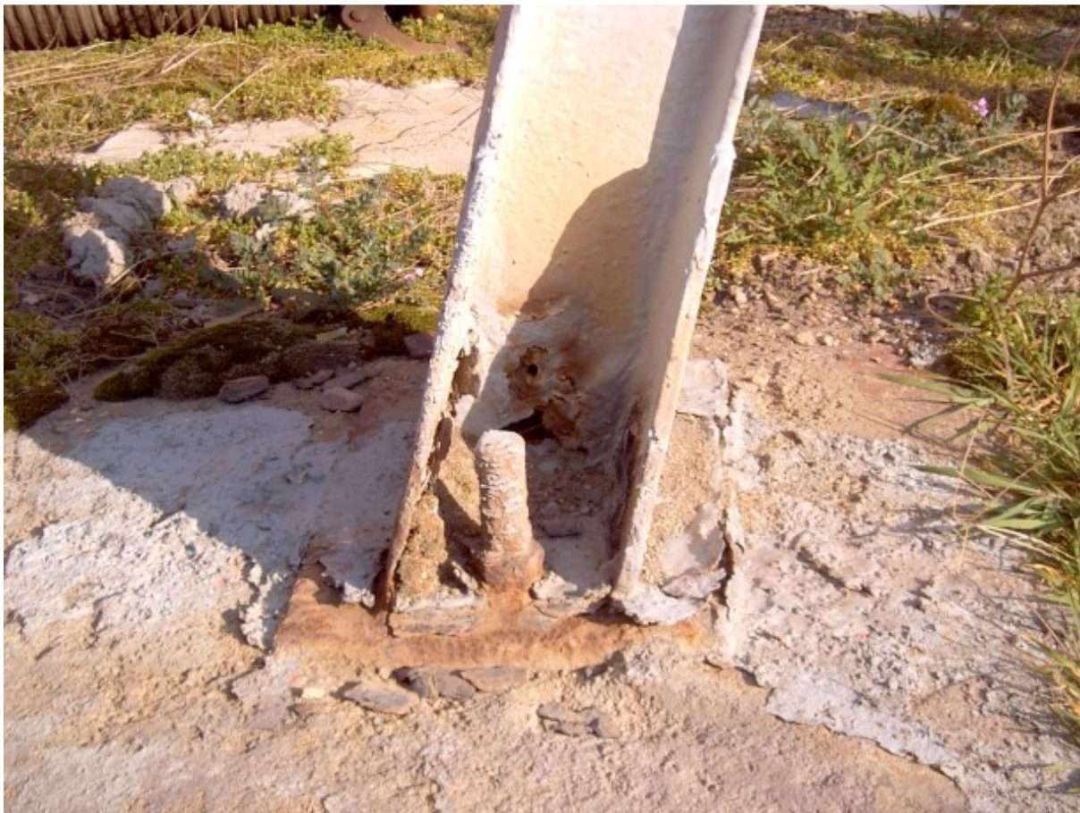
Foto 10 : prokorodovaná I stojina u sloupu 7
