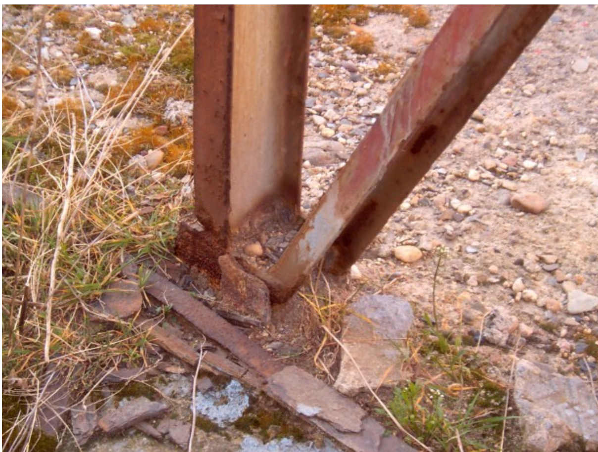
Foto 11 : zkorodovaná patní část sloupu 8
