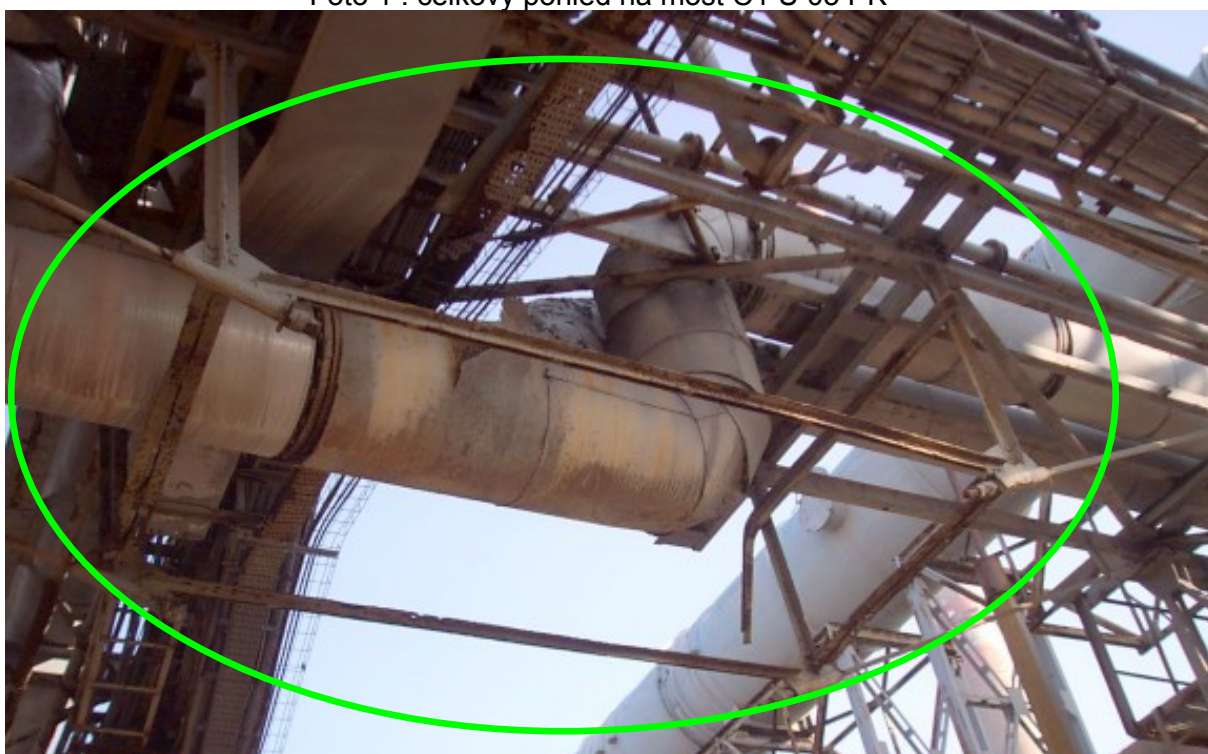
Foto 2 : korozi silně poškozené dolní ztužení lávky mezi sl. 1 - 2
