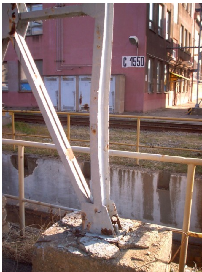
Foto 4 : pata sloupu č.2 – pravá deformovaná stojina
