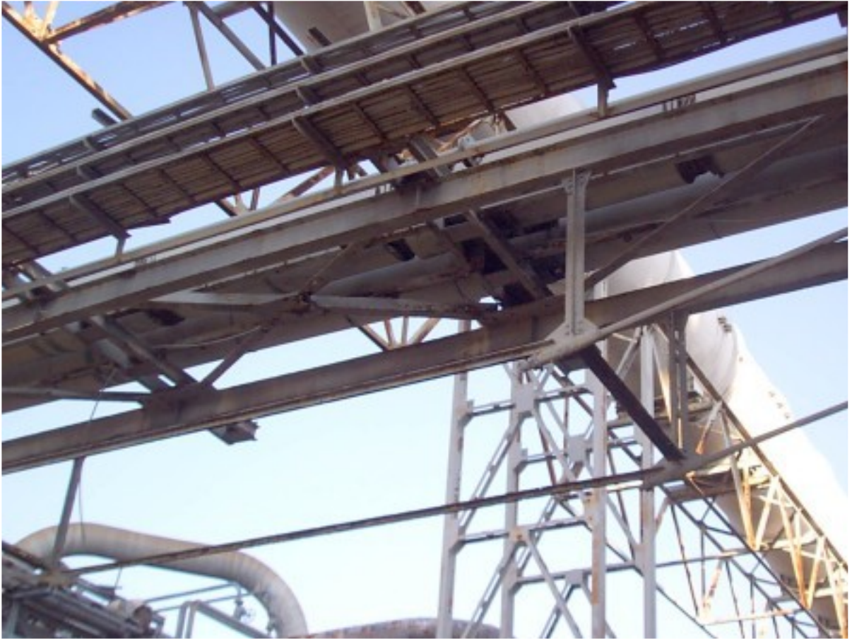
Foto 5 : korozí zeslabené dolní ztužení lávky mezi sloupy 2 - 3
