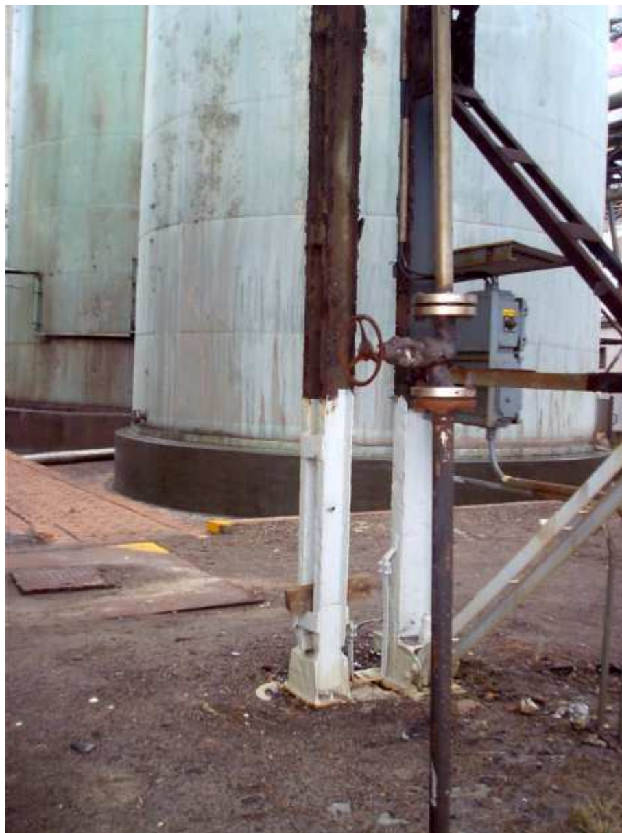
Foto 7 : vlevo zkorodovaná stojina sloupu č.10, vpravo sloup č.9
