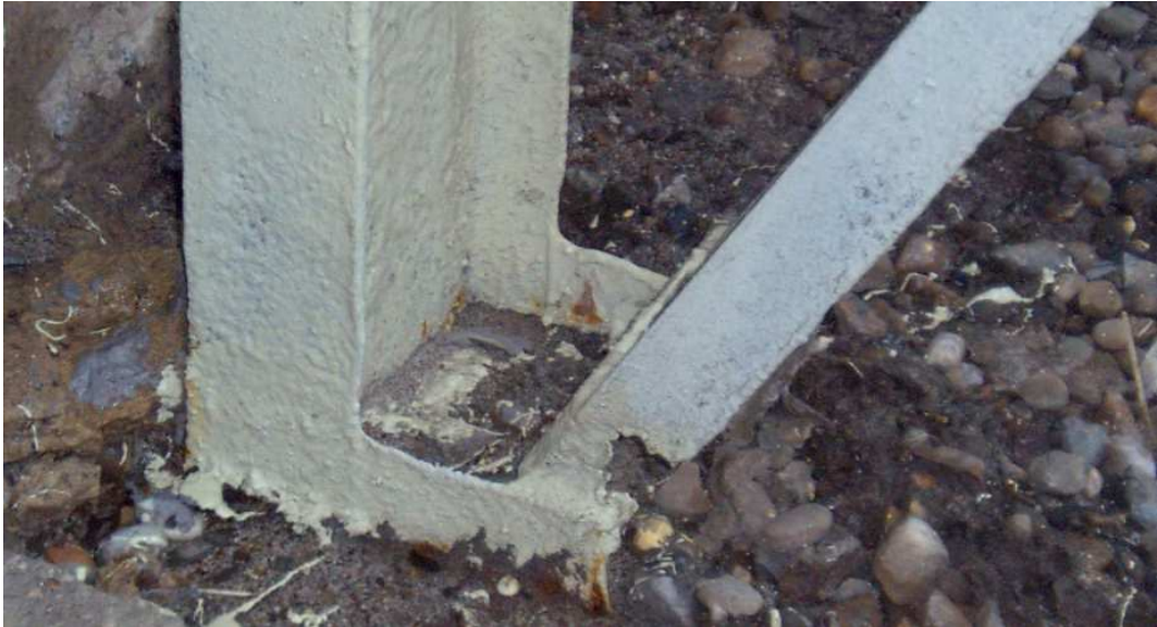
Foto 4 : pata sloupu č.5
