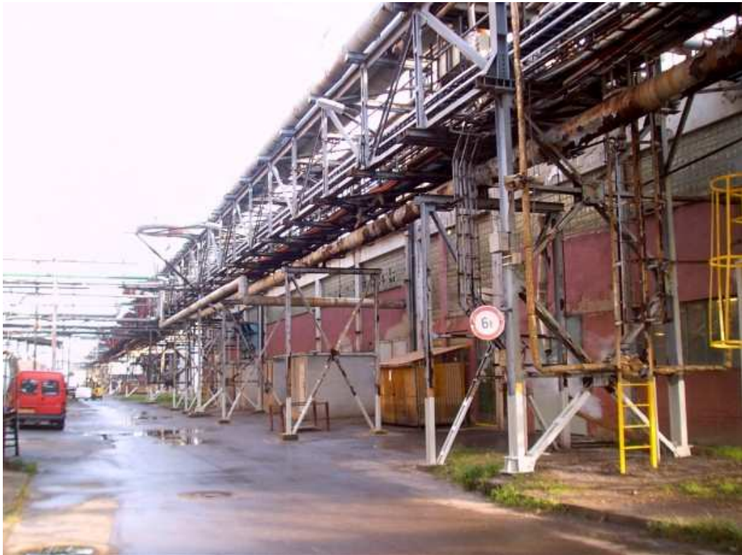
Foto 1 : celkový pohled na most D2 S05 PK
