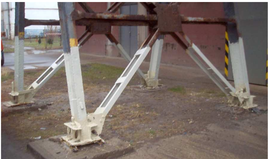
Foto 6 : korozi zeslabené paty sloupu č.7
