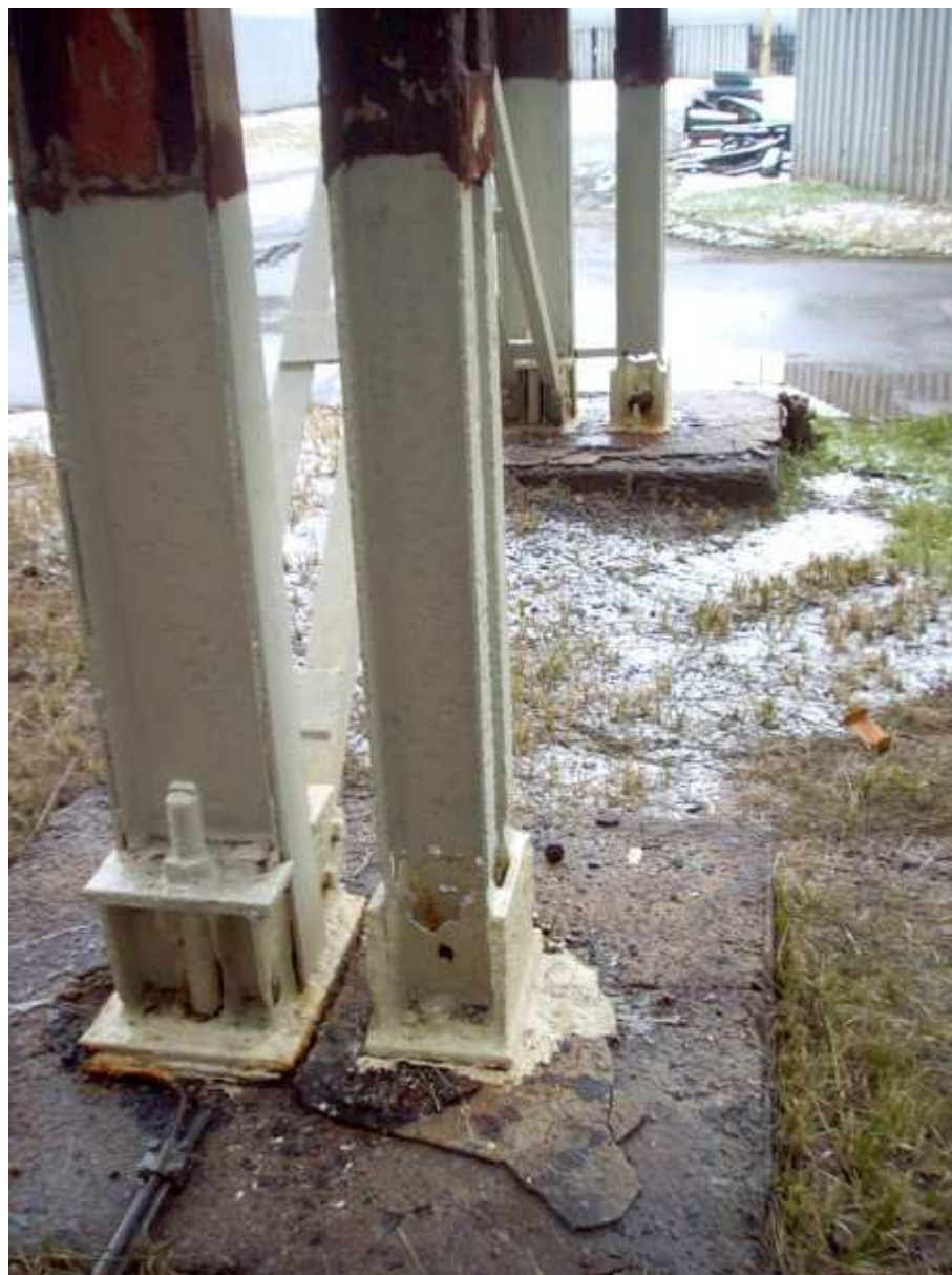
Foto 9 : vpravo prokorodované stojiny sloupu 15, vlevo stojiny sloupu 14
