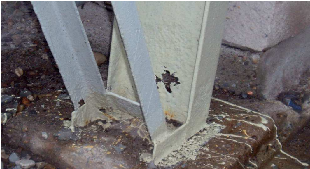
Foto 5 : pata sloupu č.6
