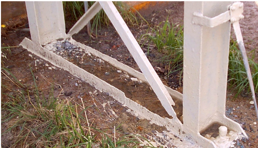
Foto 4 : pata sloupu č.5
