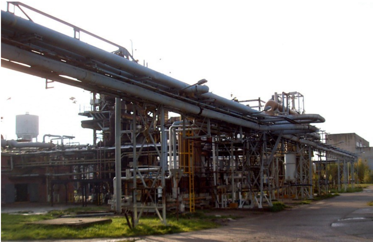
Foto 1 : celkový pohled na most C3 S05 PK
