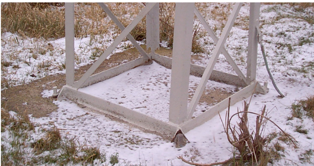
Foto 6 : korozi zeslabené L stojiny sloupu č.7
