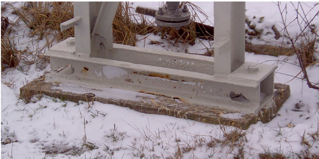
Foto 7 : prokorodovaná pata sloupu č.10
