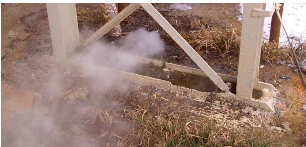
Foto 5 : pata sloupu č.6
