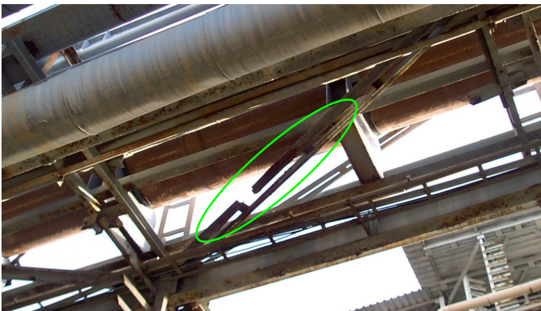
Foto 8 : prokorodovaná L výztuha lávky mezi sloupy 1 a 2
